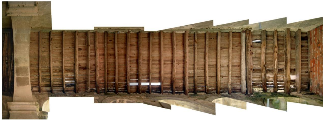
TECTO 6 – APODRECIMENTO DA MADEIRA COM RISCO DE RUÍNA DO PAVIMENTO
