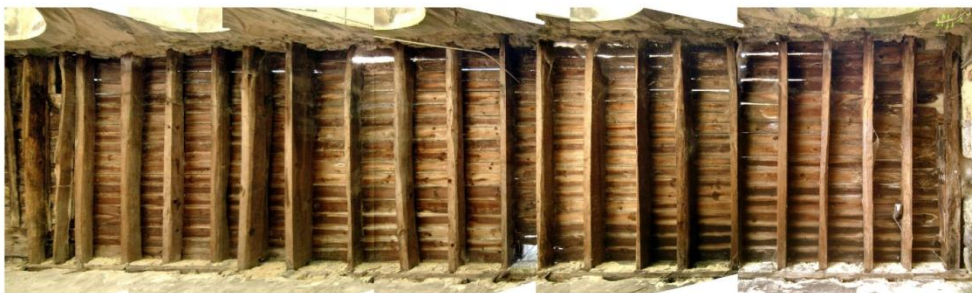
TECTO 5 – APODRECIMENTO DA MADEIRA COM RISCO DE RUÍNA DO PAVIMENTO
